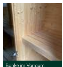
Bänke im Vorraum
